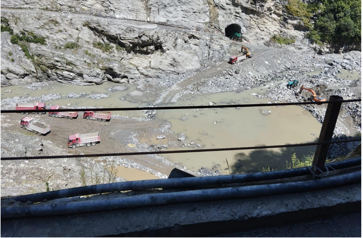
चित्र ७ माथिल्लो त्रिशुली - १ आयोजना (२१६ मे. वा.) को डाम साइट (Dam Site)
